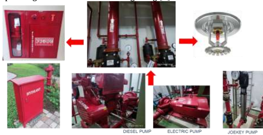
Gambar 2. Sistem Instalasi Hidrant
